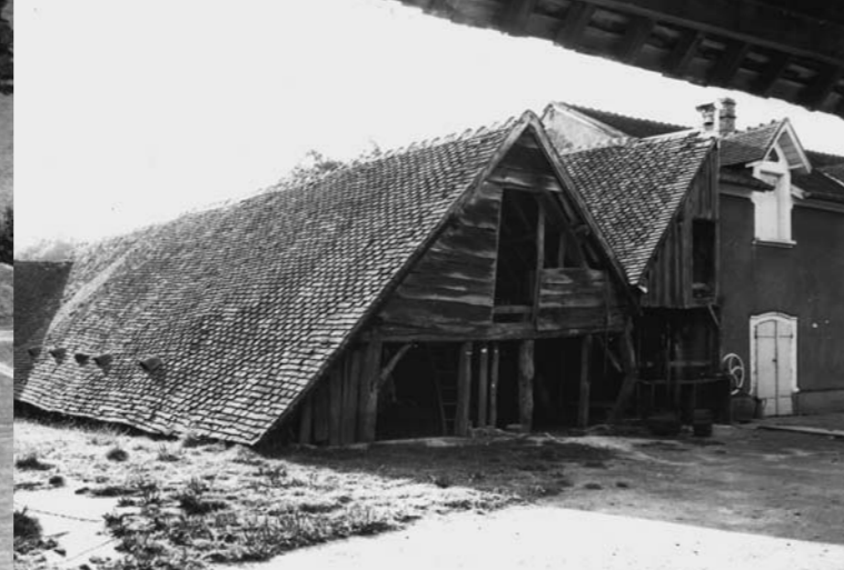
La tuilerie des Saules. Séchoir détruit. Cl. Inv. Bent Jorgensen, 1975
