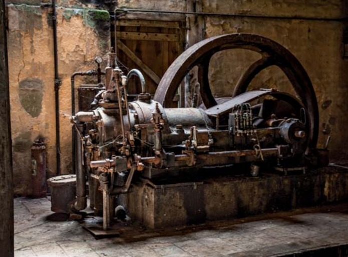
La tuilerie des Saules. Machine à gaz pauvre.
