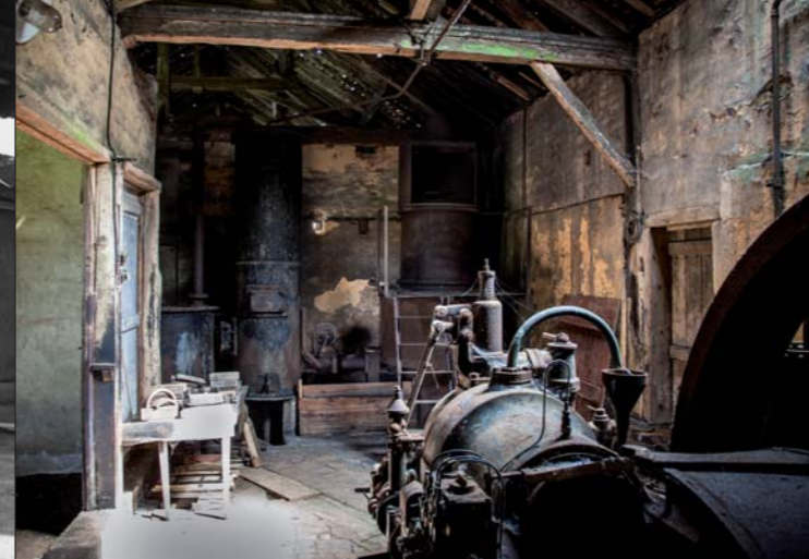
La tuilerie des Saules. Salle de la machine à gaz pauvre.
