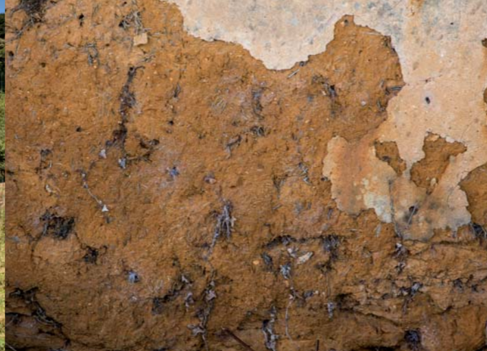
La Mussardière. Détail de mur en bauge.
