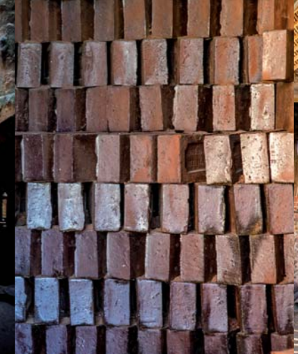
La tuilerie des Saules. Détail de la dernière fournée de briques.
