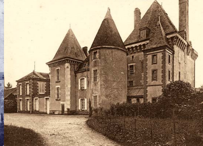
La Prousterie. Façade arrière.
