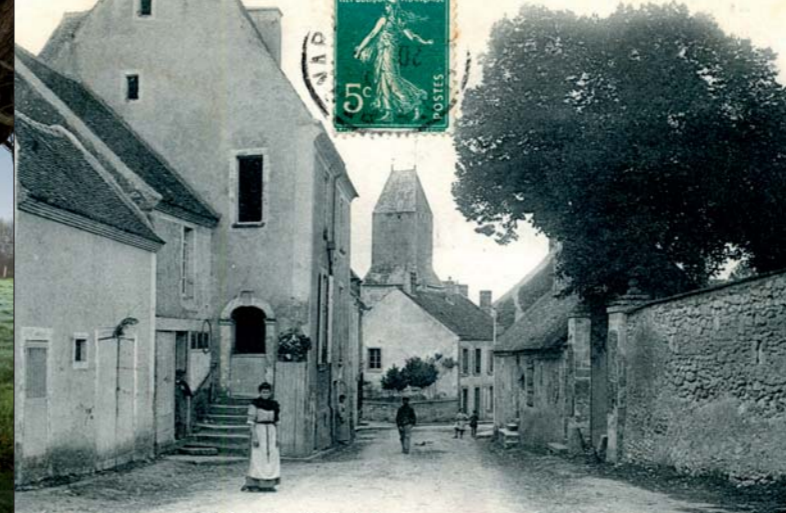
Maison dite "du Prieur" et clôture de l'ancien presbytère.
