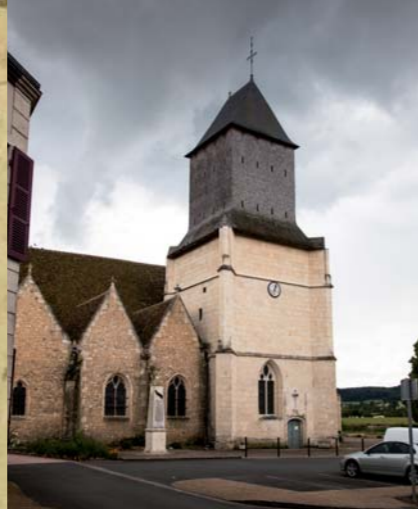
Eglise Saint-Pierre. Élévation depuis le Nord-Est.
