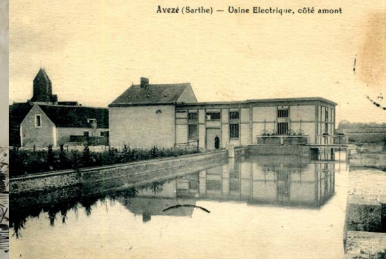
Le moulin d'Avezé, usine électrique.
