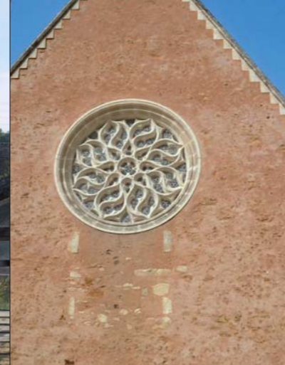
Détail de la chapelle sud, église de Beaufay.
