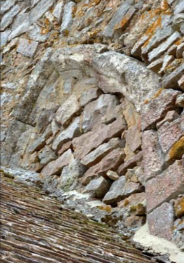
Logis de Pendloup. Détail de l'ancienne fenêtre sur le pignon gauche.
