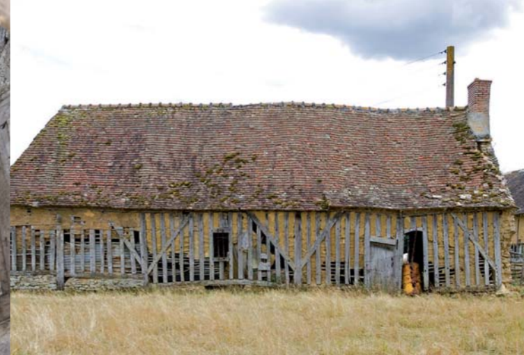
Logis de la ferme de La Pichinière, à Courcival, construit en pan-de-bois et torchis.
