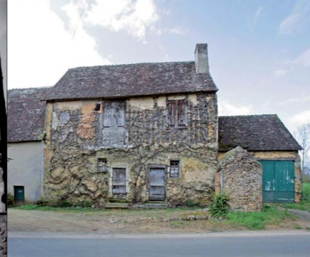
Le logis du Bordage, Briosne-lès-Sables.
