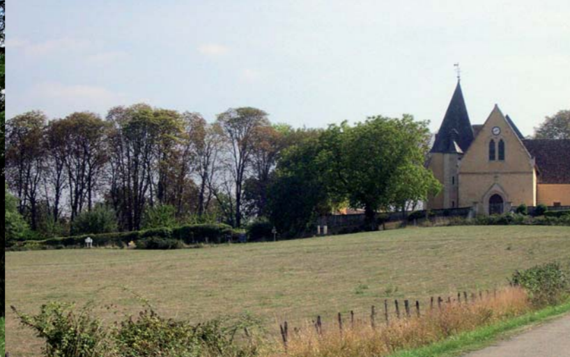
Courcival. Vue de l'église depuis la mairie.
