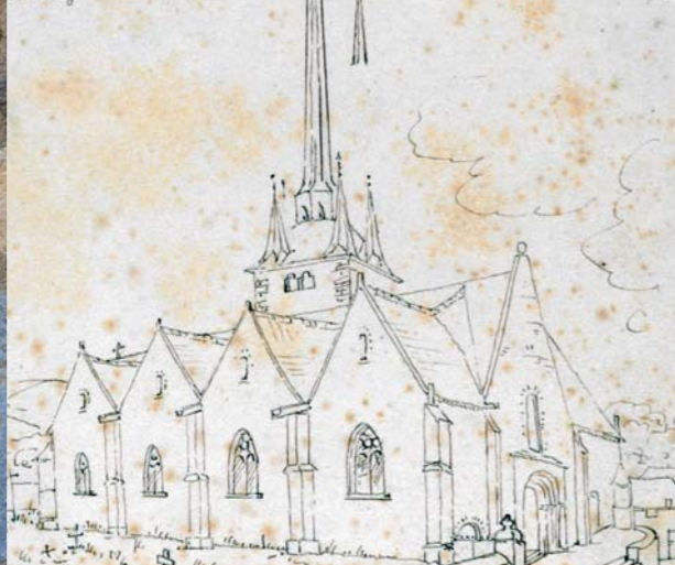
Nogent-le-Bernard. Vue de l'église en 1821, avant l'effondrement du clocher.
