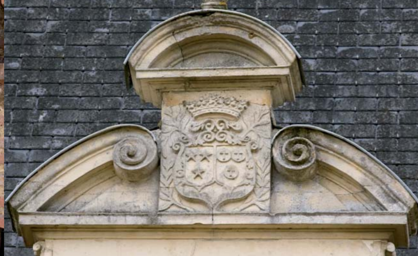
Couronnement d'une lucarne, château de Courcival.
