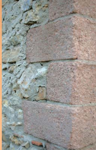
Détail de construction en parpaings pleins similaires à ceux de La Goude. La Boussardière, Courcival.
