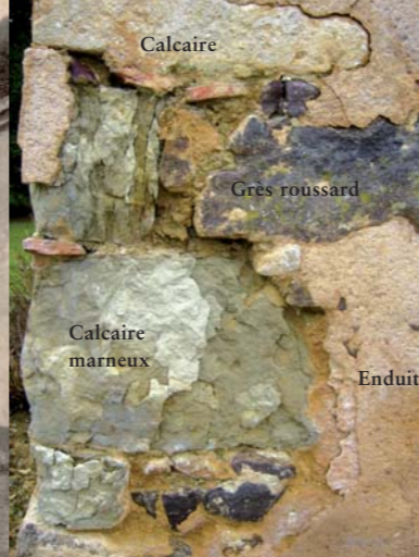
Détail de la maçonnerie de moellons, église de Terrehault.
