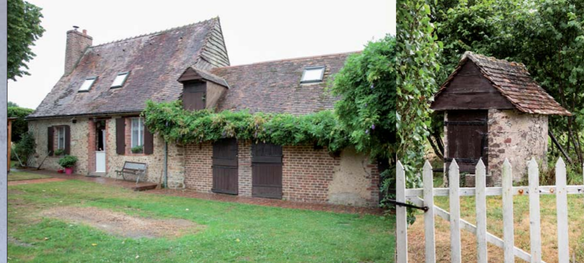
Le Loquet à Tresson, vue d'ensemble.
