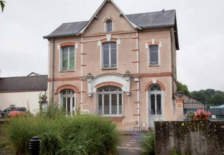
Ancienne poste de Tresson.
