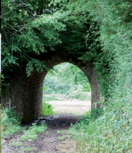
Ferme de Vauboulon à Tresson, ancien pont du tramway.
