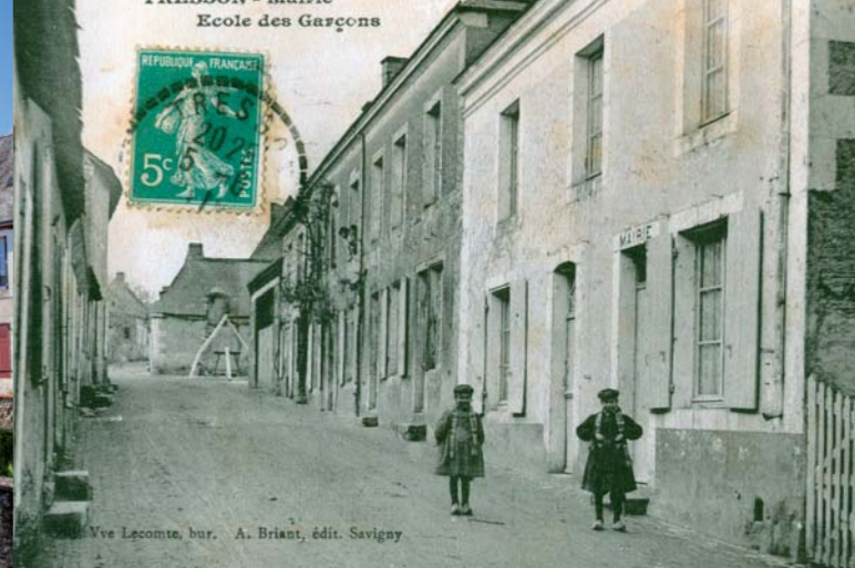
Ancienne mairie-école de Tresson, mairie de 1881 à 1952 et école des garçons de 1881 à 1965.
