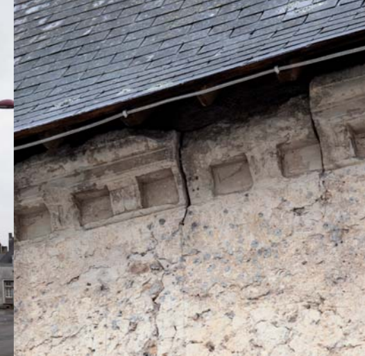
Détail de corniche, église de Maisoncelles.
