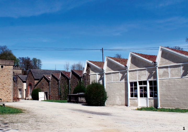
1. Ce bâtiment couvert d'une toiture en « sheds » sur le modèle des usines anglaises a été construit à côté de l'abbaye en 1894 par Gustave Denis.
