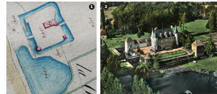
1 Plan cadastral du château de la Grande-Maison, 1836. Archives départementales de la Sarthe, section A3 de la Grande-Maison, PC\167\005. 2 Vue aérienne du château de la Grande-Maison au milieu du XX e siècle.
