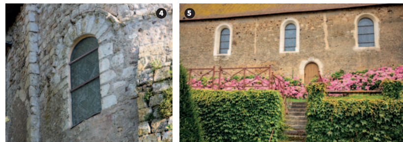
4 Baie romane du chevet. 5 Mur sud de la nef.
