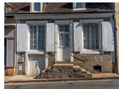
La façade principale de la maison dite de Tisserand.
