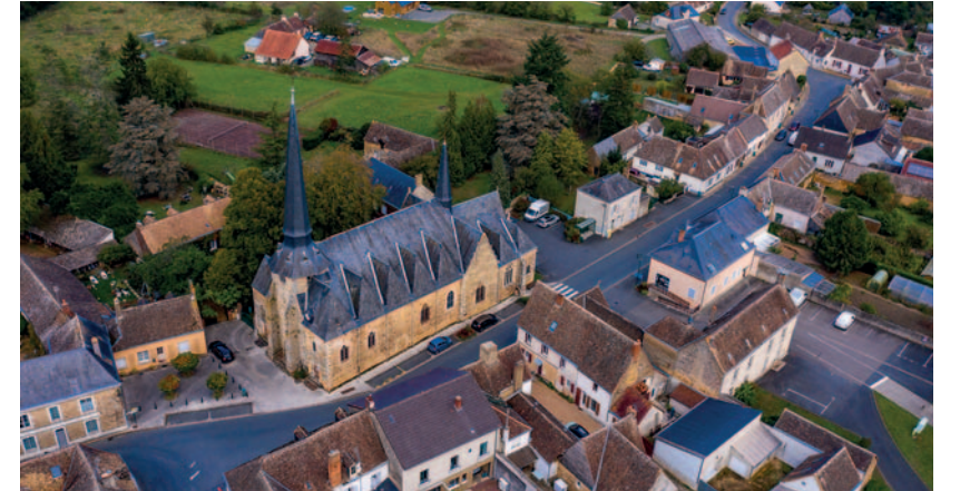
Vue aérienne du centre-bourg.
