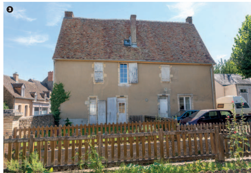
Maison au 7 rue Notre-Dame : ❶ Baie chanfreinée de la façade ouest. ❷ Ferrure portant la date 1785. ❸ La façade ouest.
