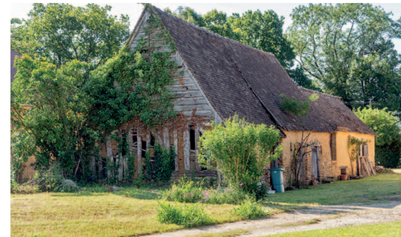
Bâtiment agricole de l'ancien bordage du Thuau.
