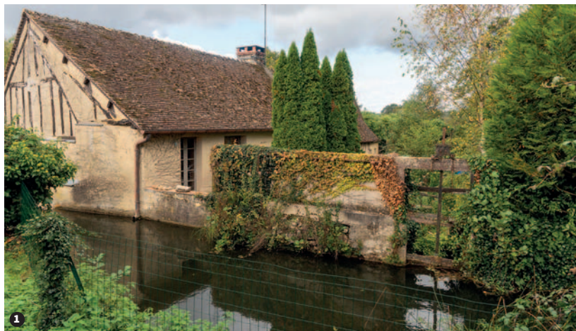
Moulin de Cherruau : 1 Le bief, la vanne de décharge et le bâtiment sur lequel s'appuyaient les roues. 2 Le mécanisme. 3 La chute d'eau qui alimentait la roue en pignon. 4 La charpente d'assemblage de la grange.
