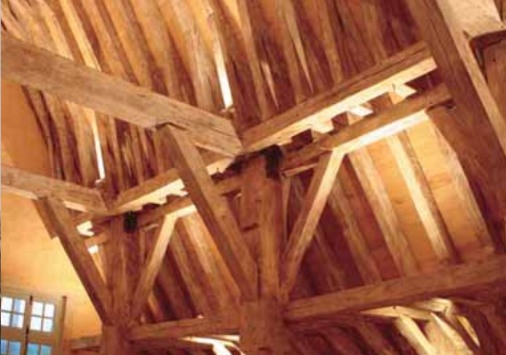
Charpente en chêne des halles, restaurée en 2006-2007.
