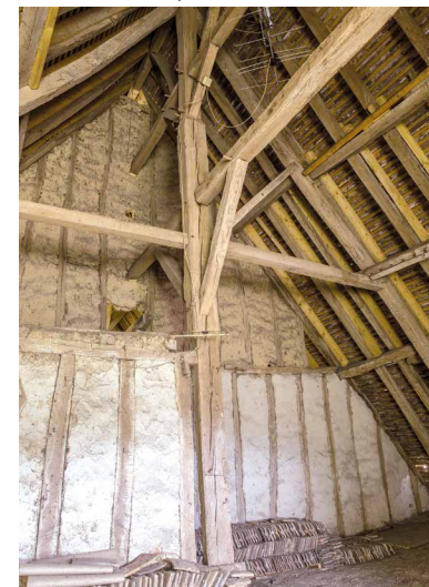
Le comble, détail de la charpente et d'une cloison en pan-de-bois.
