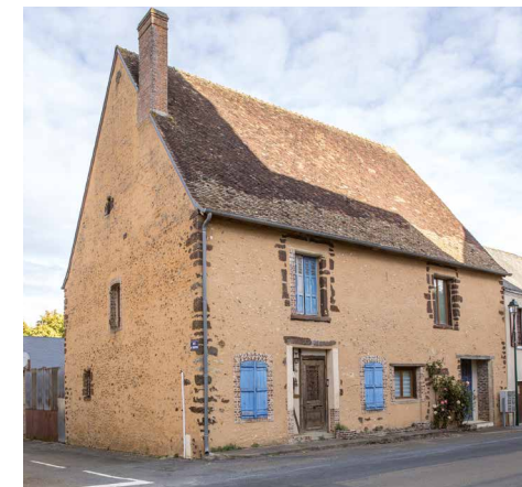
L'ancienne maison seigneuriale, la façade sur rue.
