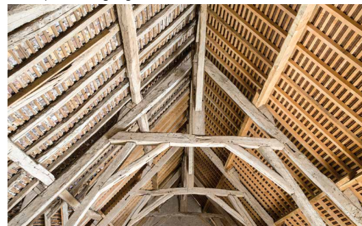
La charpente de la grange.
