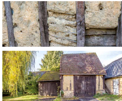
Granges en pan-de-bois et détail de mise en œuvre.
