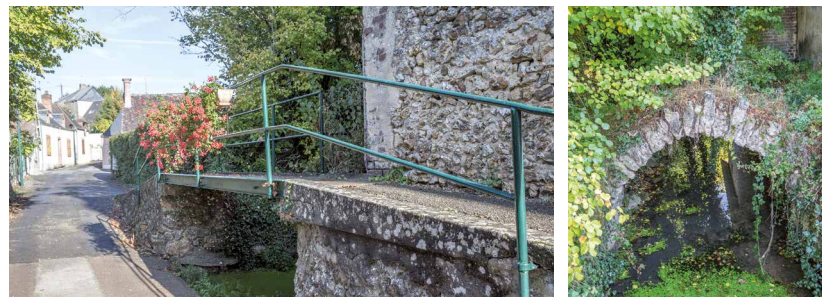
Passage à gué, passerelle et petit pont maçonné sur le Boutry.
