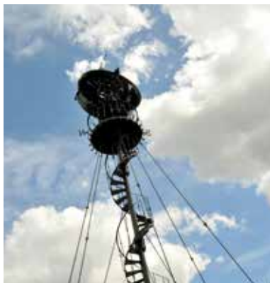
Éolienne Bollée © Ville du Mans.
